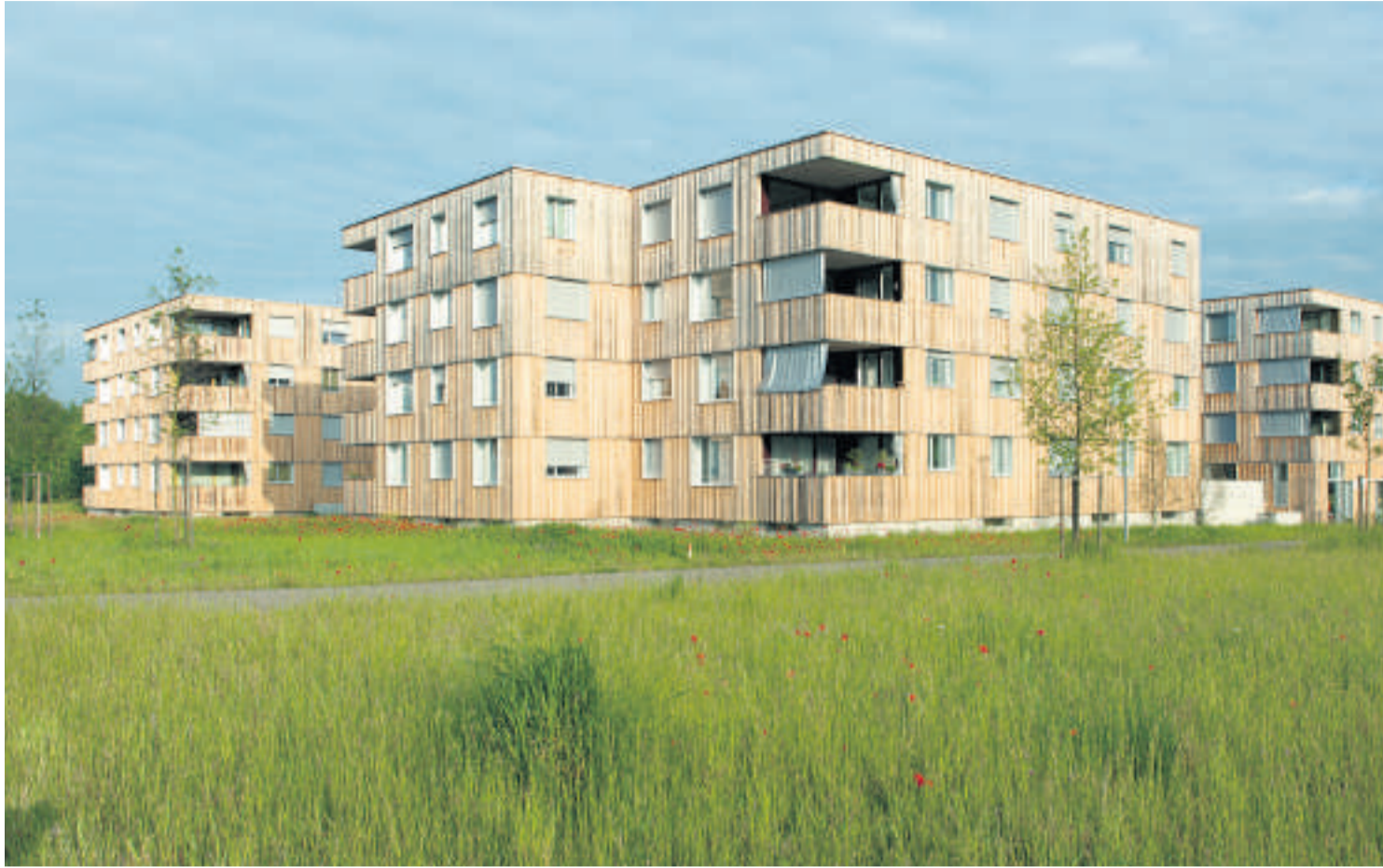
Hausschalung aus unbehandelten Weisstannenlatten: Wohnsiedlung Im Gries der Zürcher Baugenossenschaft Bahoge
